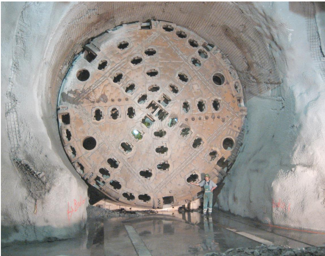
Рис. 1. Вид на режущую часть ротора щита ТПМК Lovat.
