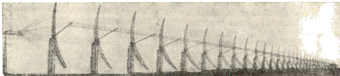
Рис. 15. Линия восток — запад крестообразного интерферометра Физического института
