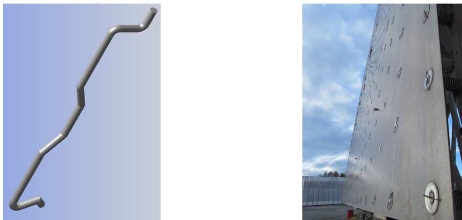
Рис.1. Модель пружинного фиксатора и поверхность щитов Плоского отражателя РАТАН-600 с пружинными фиксаторами на кречно-юстировочных винтах.
